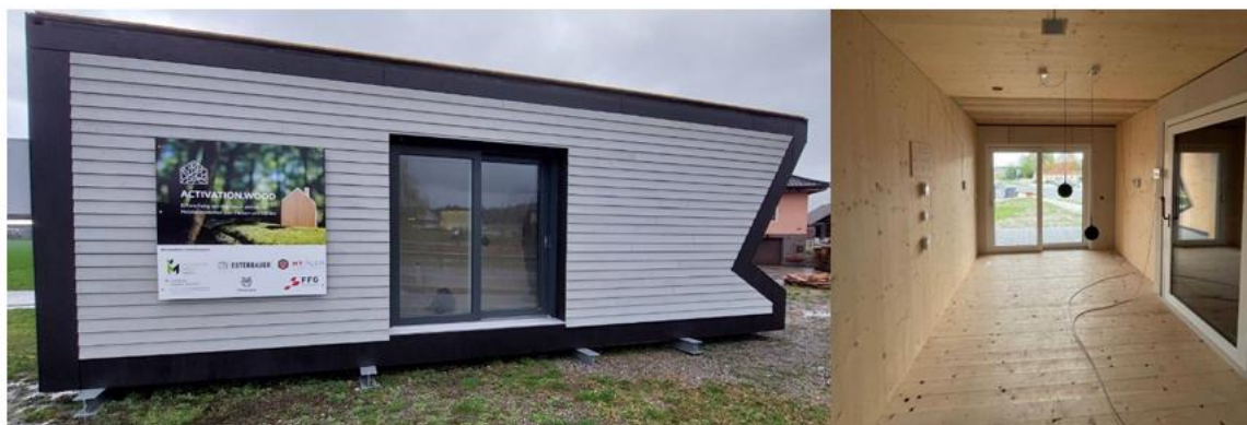
Abbildung 1 Außenansicht und Innenansicht der Forschungsanlage mit thermisch aktivierter Holzdecke.
