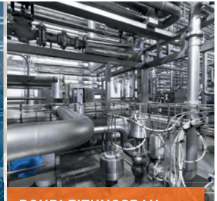
ROHRLEITUNGSBAU für Clean & Black Utilities (gem. cGMP und GEP Standards)
