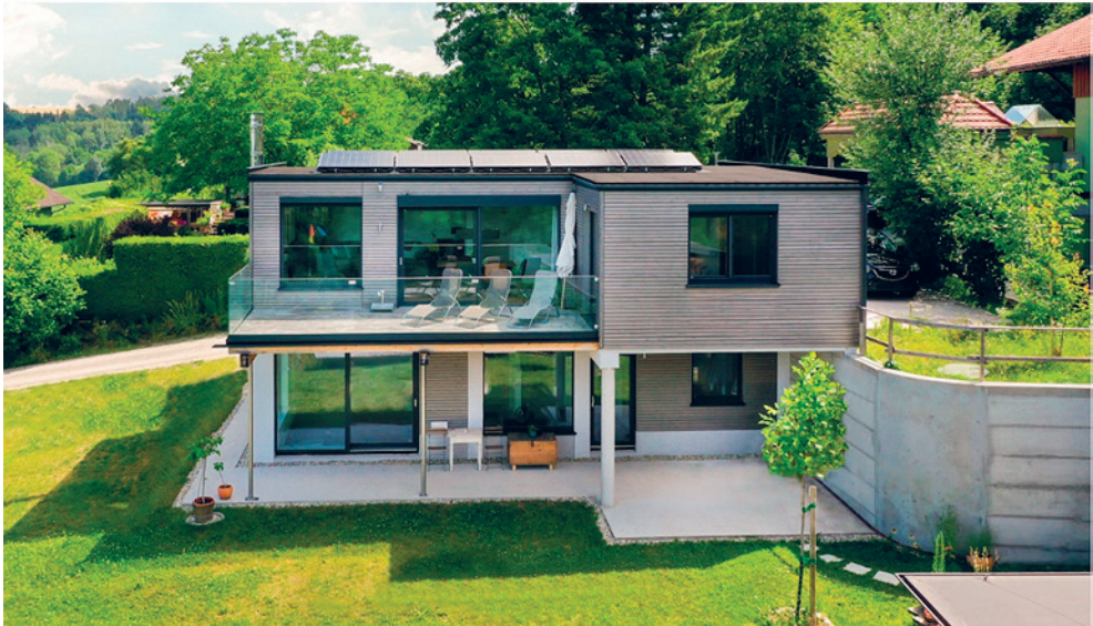
Abb. 1: Wohngebäude in Modulbauweise (Foto: Seifriedsberger/Genböck)
