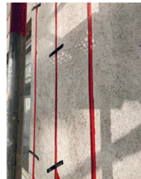
Abb. 4: Gefräste Fassade (Große Neugasse) mit Rohren und Befestigung
