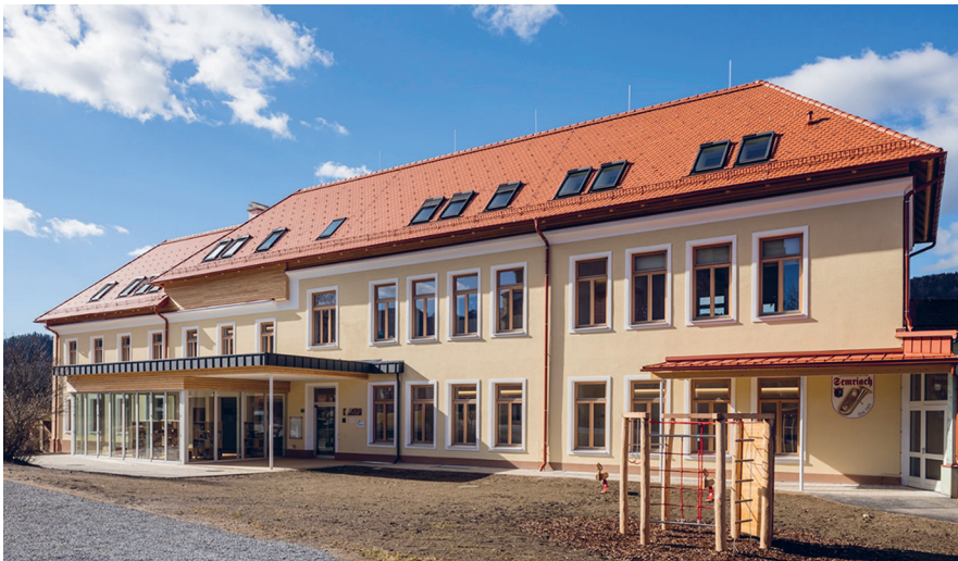
Abb. 2: Foto der Volksschule Semriach nach der Sanierung und Erweiterung (volksschule-semriach.at 2021)
