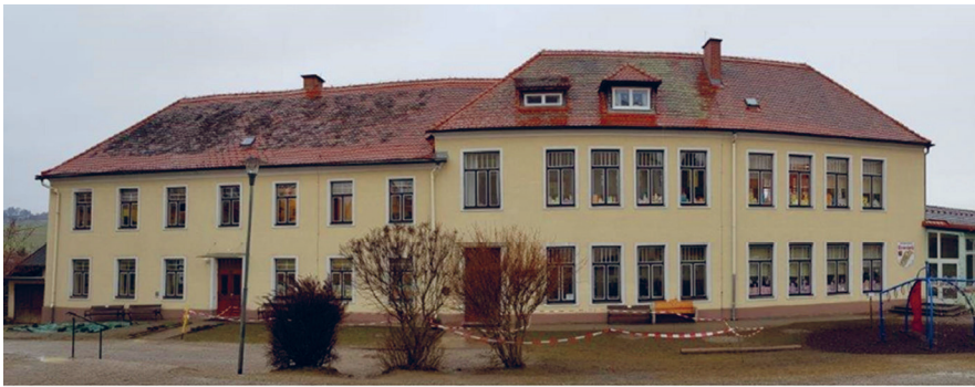
Abb. 1: Volksschule Semriach vor der Sanierung und Erweiterung (ARCH+MORE ZT GmbH 2021)
