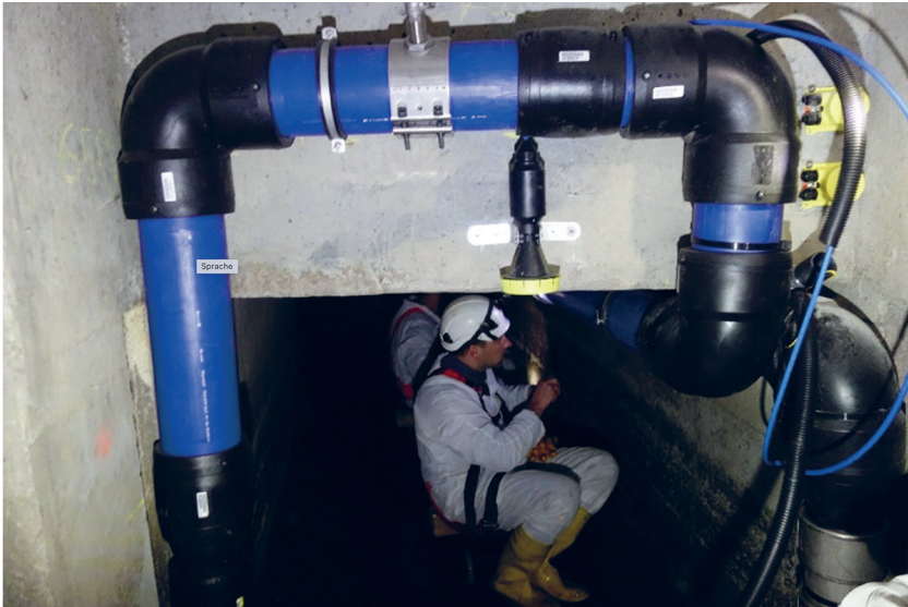
Abb. 4: Montage der Zu- und Rückleitungen sowie des Monitoringsystems im Kanal, Blick auf mittig angebrachten Füllstandssensor (Foto: Wiedemann)
