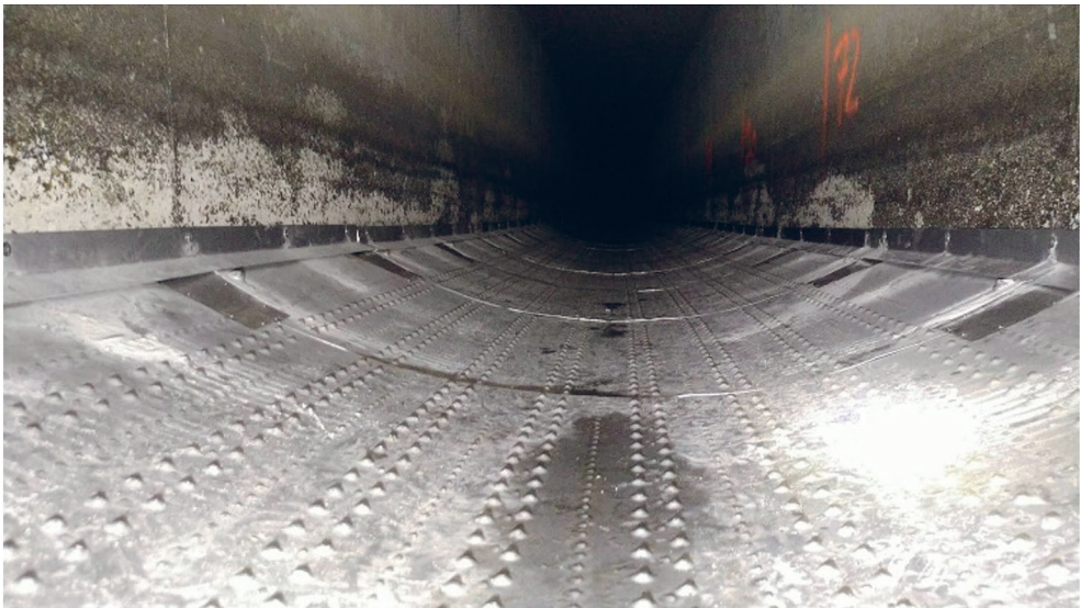
Abb. 3: Fertig-montierte, genau an die Konfiguration des bestehenden Kanals angepasste, Wärmetauscher (Rabmer-Uhrig /Therm-Liner, Foto: Wiedemann)
